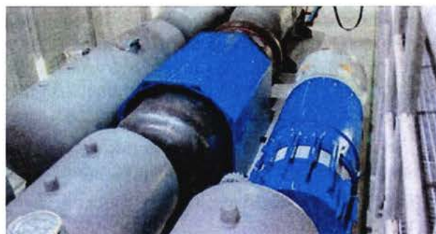
Foto 11. Greifswald ZLN-BRD: Opslag reactorvaten grote componenten. Vat Rheinsberg ligt rechts.
