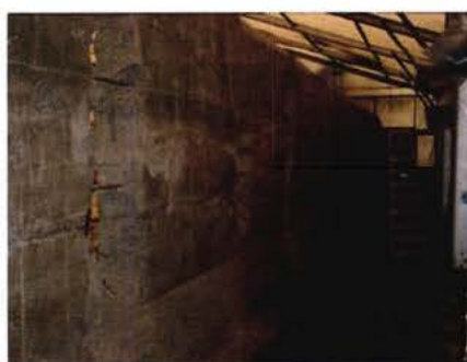
Foto 6. Eurochemie-Mol, België: beton verwijderd uit wand voormalig bezinkbassin.
