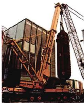
Foto 12. Berkeley-UK: Stoomgenerator wordt uitgehesen.
