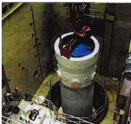
Foto 10. Rheinsberg-BRD: uithijzen reactor in één stuk.
